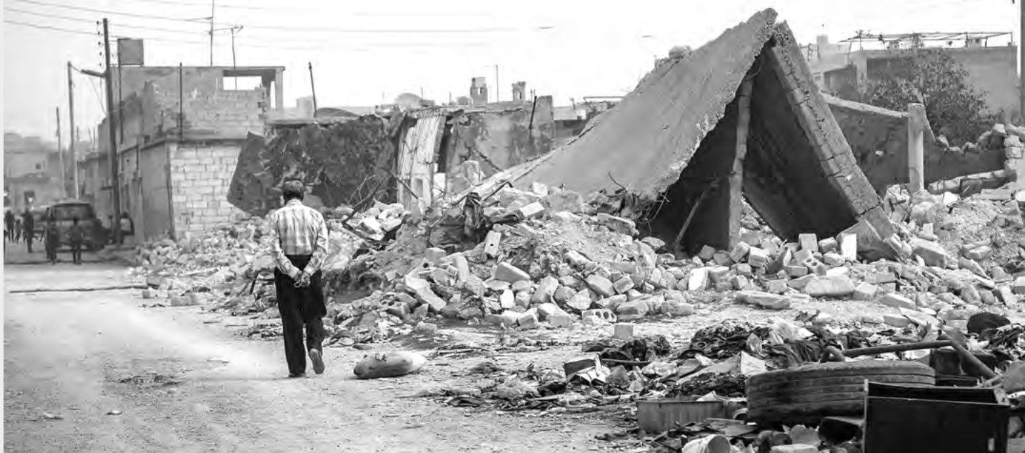
Alto grado de daños, destrucción y desplazamiento en Aleppo. Fotografía: ACNUR/Antwan Chnkaji, octubre de 2018
